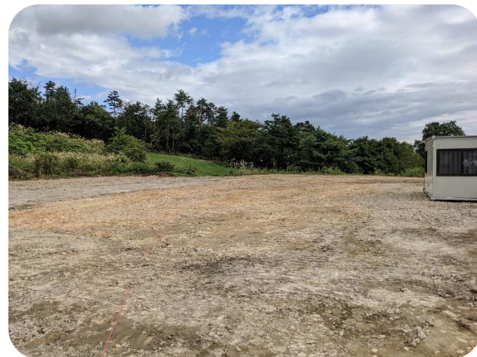
畜舎改築進んでいます。豚舎が更地に。
