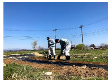
防水シート張り
