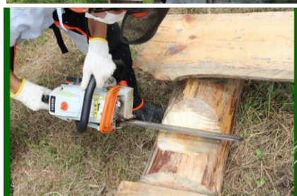
丸く切り込みを入れてフィットさせる！
