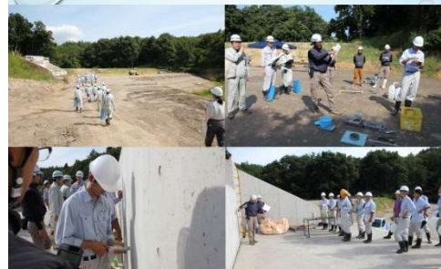
飯坂ため池堤体工事見学(8月30日)
